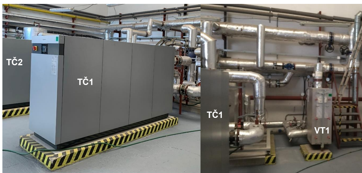
Obrázok 11: Technológia kotolňa K5 – tepelné čerpadlá
