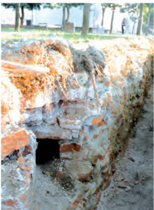
Výkopom preťatá klenba a pivničný vetrák bývalého zájazdného hostinca Zlatý gryf, v pozadí budovy firmy Hubert.
