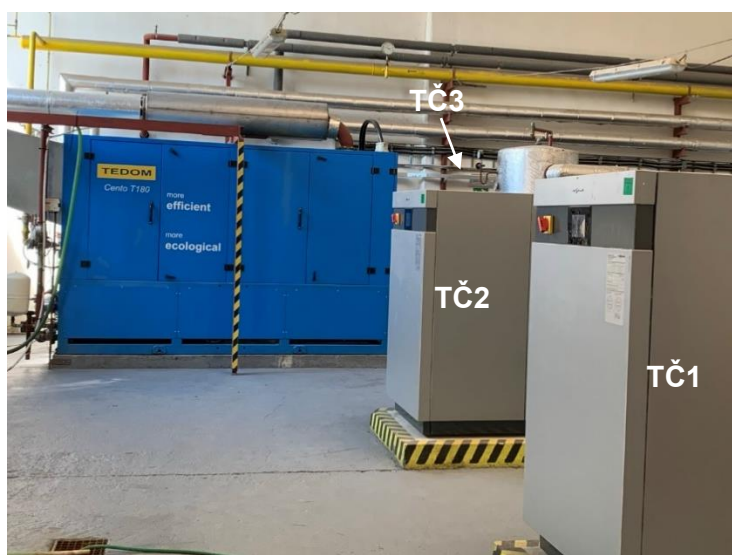
Obrázok 12: Technológia kotolňa K5 – kogeneračná jednotka a tepelné čerpadlá
