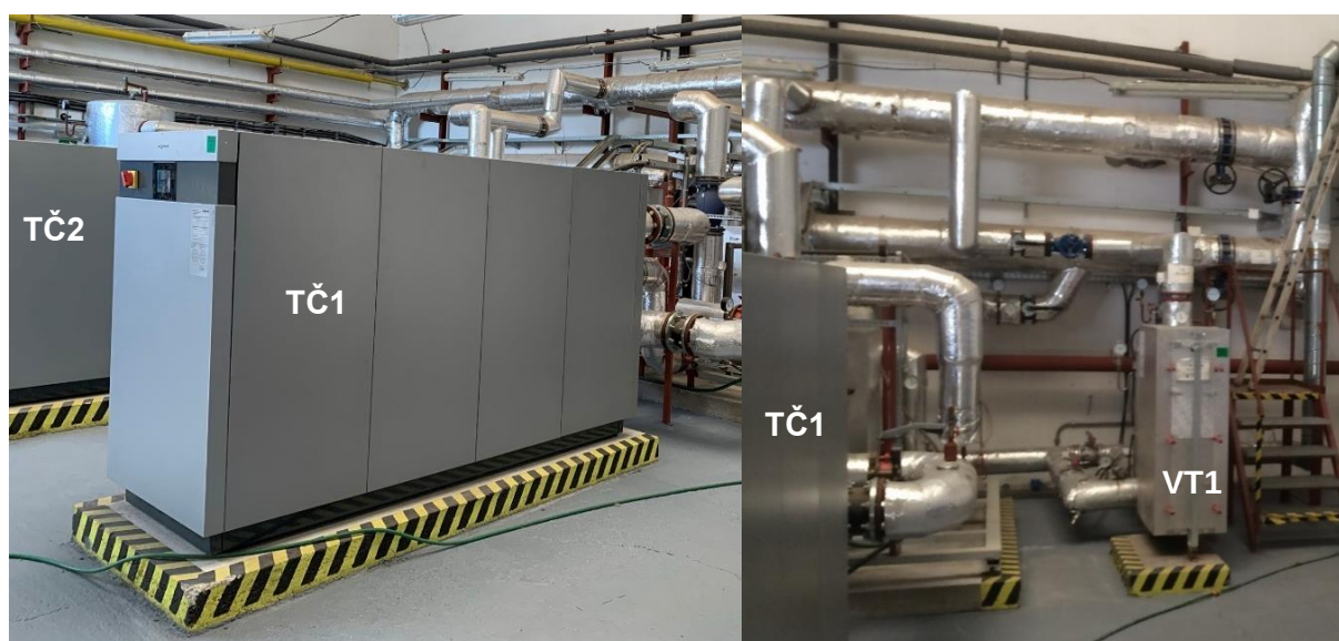
Obrázok 11: Technológia kotolňa K5 – tepelné čerpadlá
