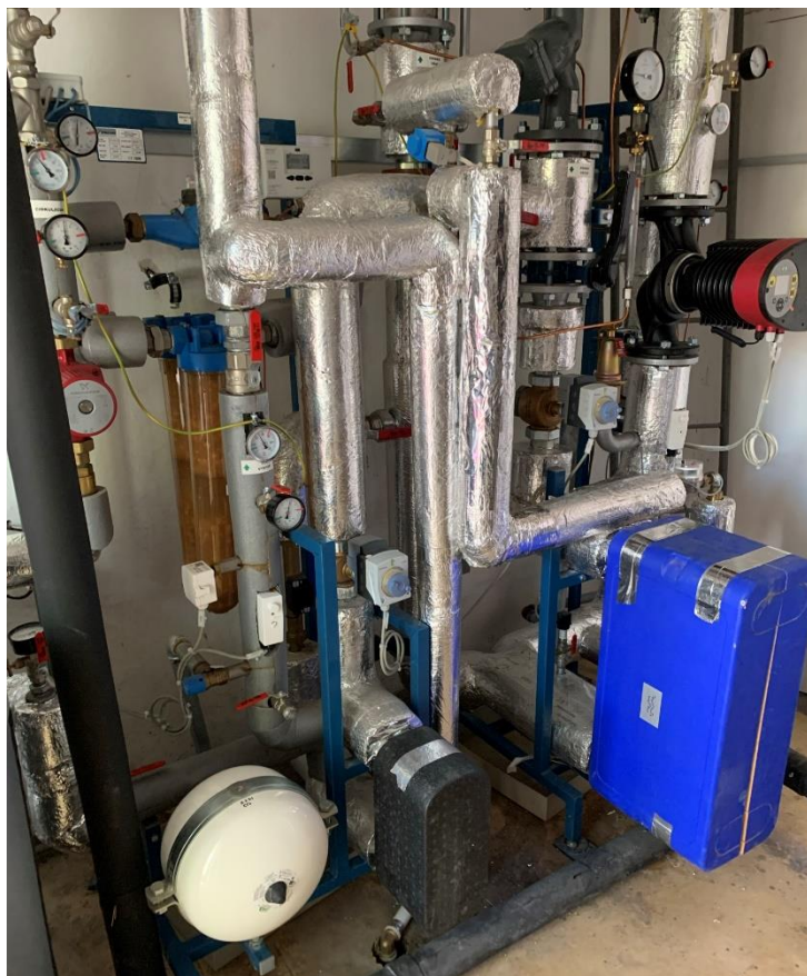
Obrázok 13: Príklad rekonštruovanej OST
