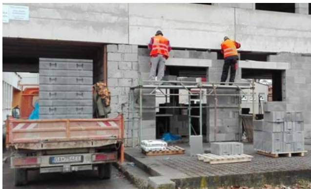
Začala sa prestavba pavilónu G.
