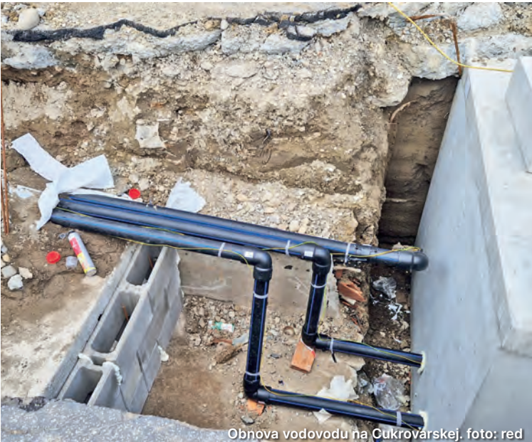
Obnova vodovodu na Cukrovarskej. foto: red
