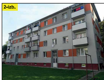
2-izb. 50.000 EUR PREDAJ - Sered', Čapeňská 2-izb. OV, balkón, pivnica, plast. okná, slušný pôvodný stav. ☎ 0905 674 932 ID247337
