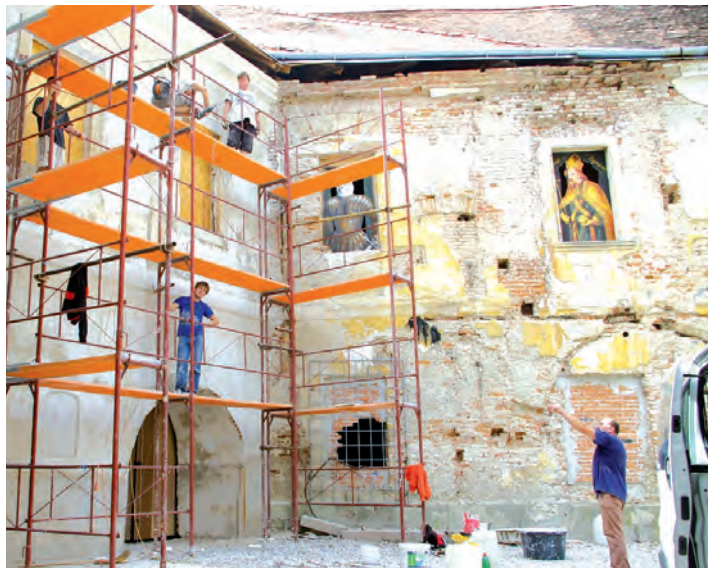
Reštaurátori obnovili pôvodnú omietku.
