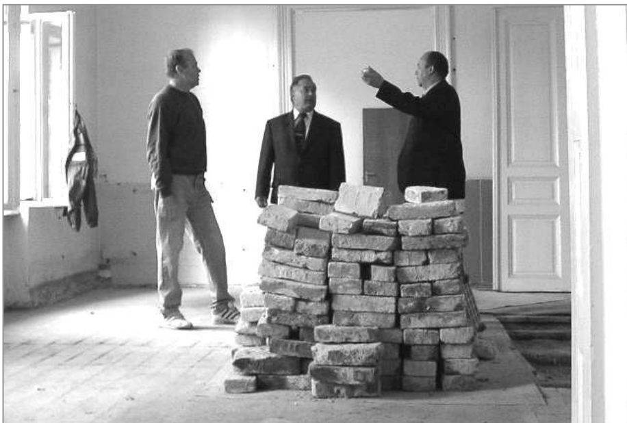
Primátor mesta Ján Lehota so zástupcom primátora Ing. Antonom Pančíkom a J. Matisom na kontrole postupu rekonštrukčných prác.
