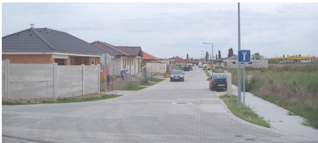
Výstavba nového obytného súboru v Strednom Čepeni - Prúdy I. sa už rozbehla. Po dokončení tu nájdú nový domov mladé rodiny v 31 rodinných domoch.
