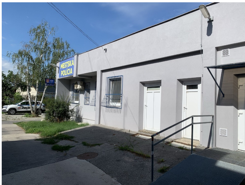
Obrázok 33: Zrekonštruovaná budova Mestskej polície Sereď
