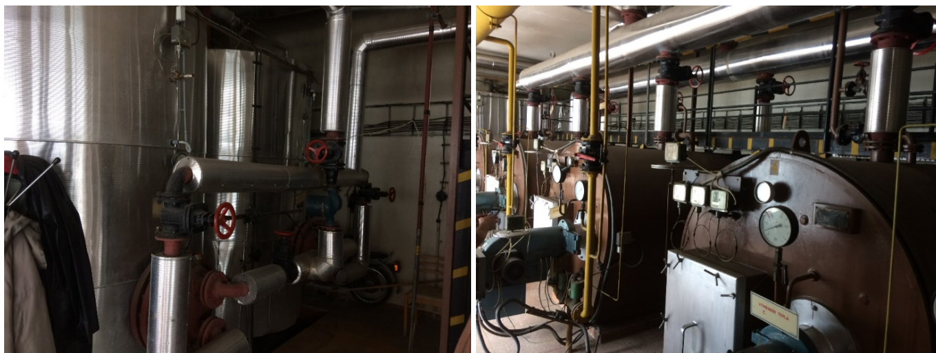
Obrázok 43: Kotolňa – vľavo akumulčné nádoby na TV, vpravo kotly
