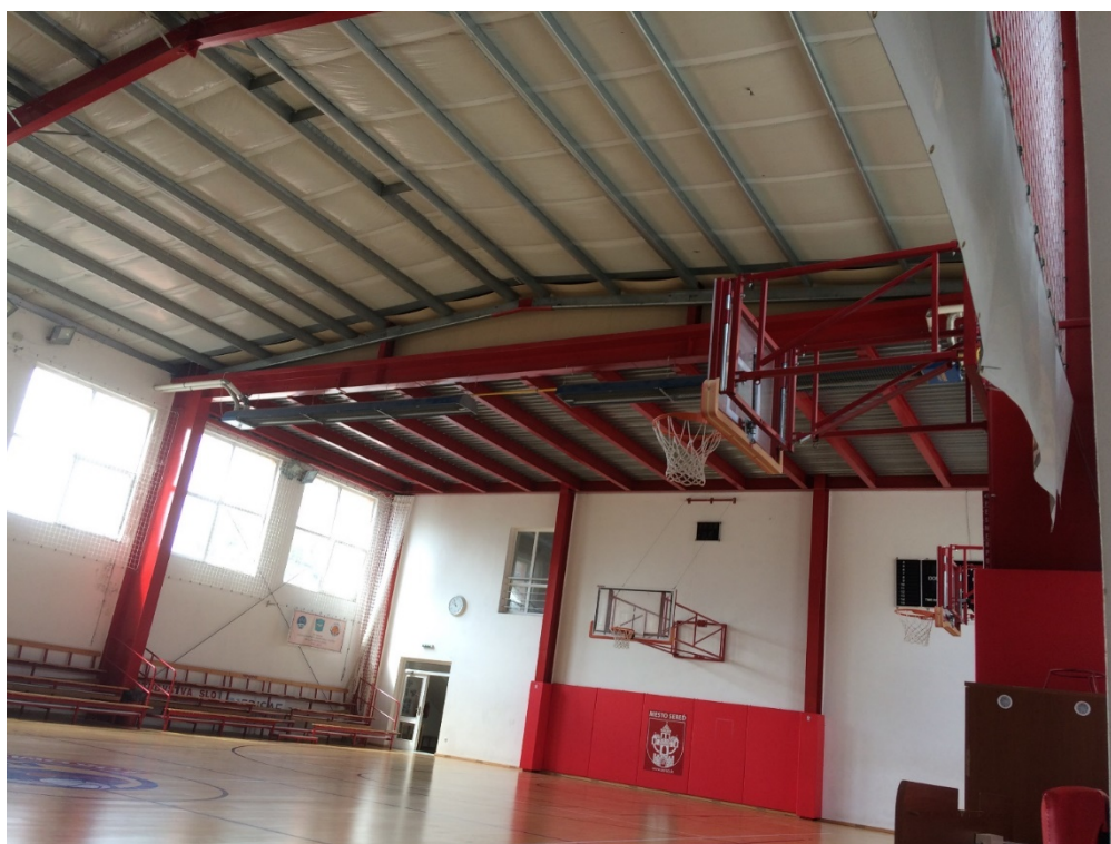
Obrázok 54: Interiér športovej haly Sokolovňa – vykurovanie infražiačmi, reflektorové osvetlenie
