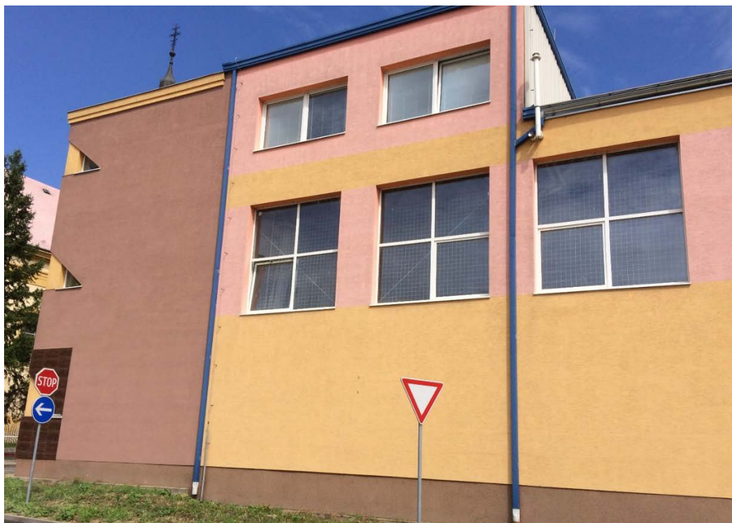
Obrázok 53: Športová hala Sokolovňa – ľavá dvojpodlažná ubytovacia časť, pravá časť priestor športovej haly
