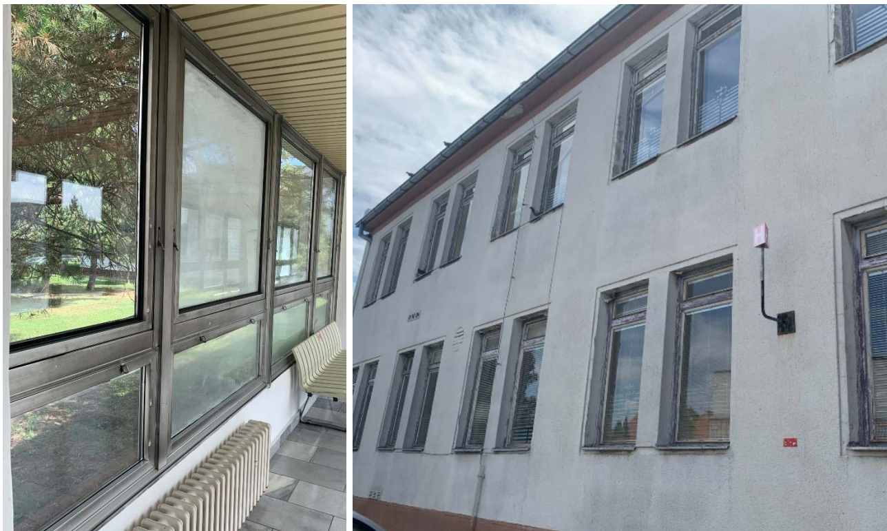
Obrázok 44: Pôvodné kovové, resp. drevená okná – spojovacia chodba s blokom D, resp. kolmá časť bloku B
