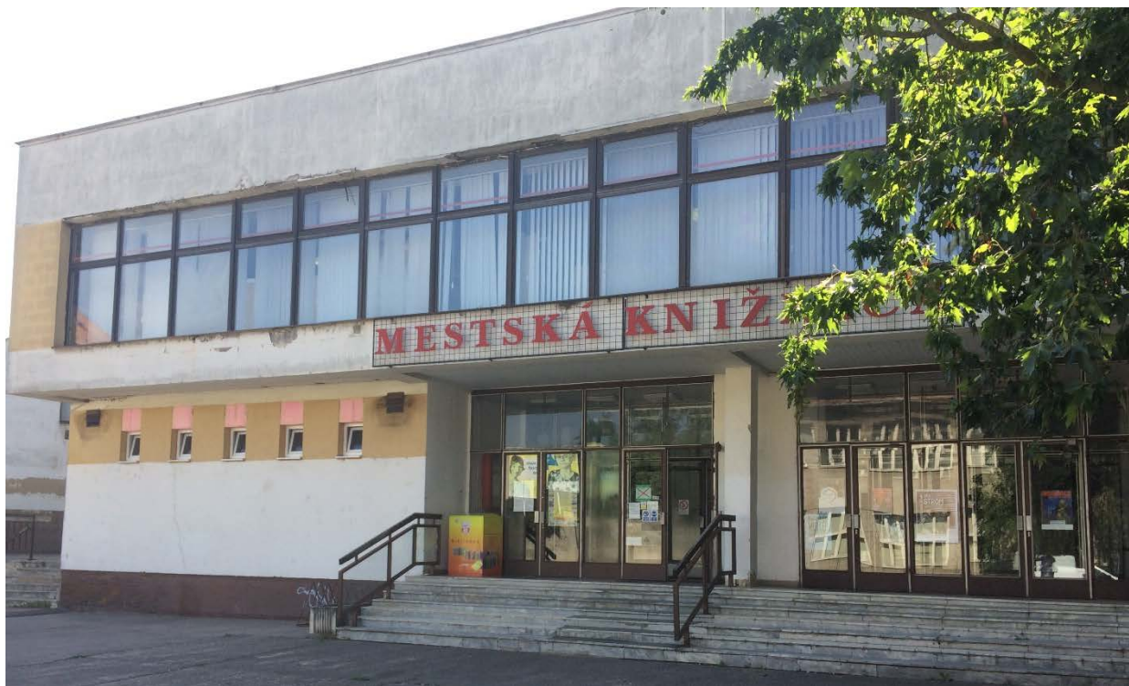
Obrázok 47: SZ Strana objektu – vstup do mestskej knižnice, pôvodné kovové výplne otvorov
