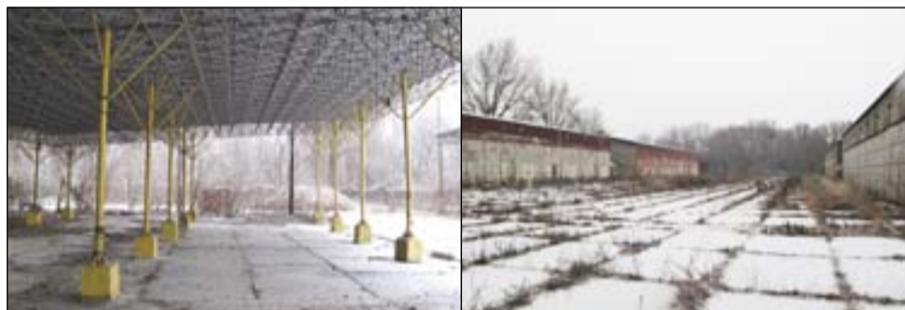
kontrola elektroinštalácie objektu
